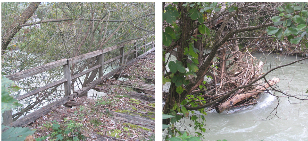
Slika 4: Most gorvodno od sotočja Meže in Mislinje (levo). Plavje ob mostnem oporniku (desno). Fotografiji posneti dne 24.9.2010 (FOTO: G. Novak)
