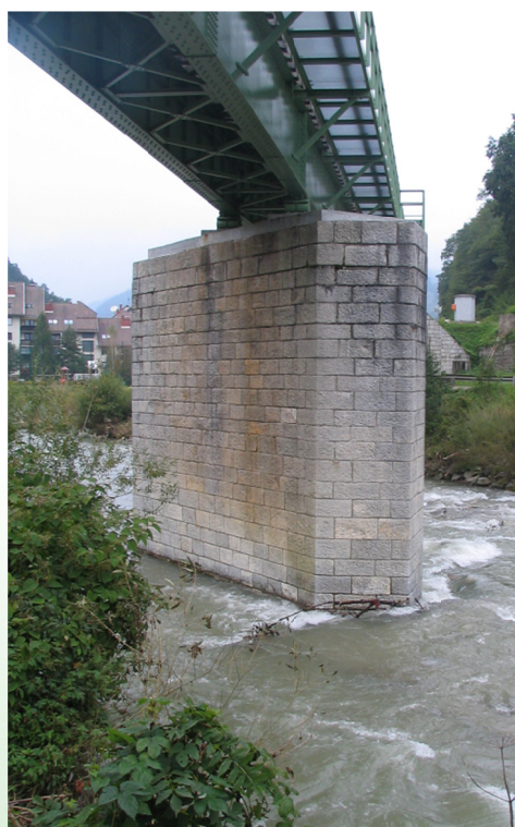
Slika 9: Mostni opornik železniškega mostu (FOTO: G. Novak)
